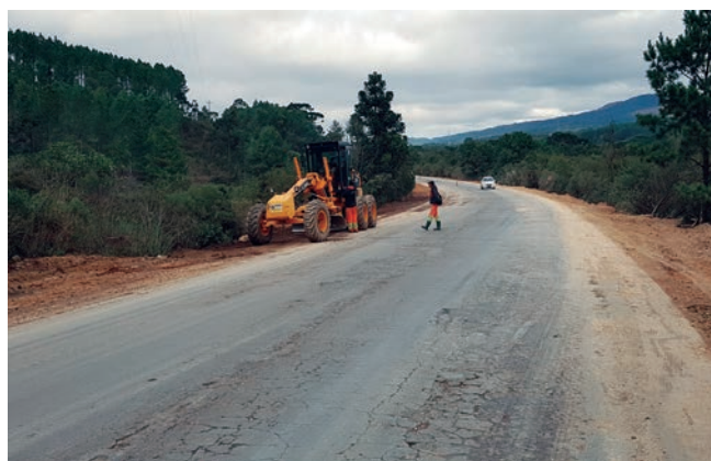
figura 1 - Pavimento asfáltico existente
