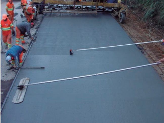
figura 7 - Acabamento do concreto com float manual e texturização
