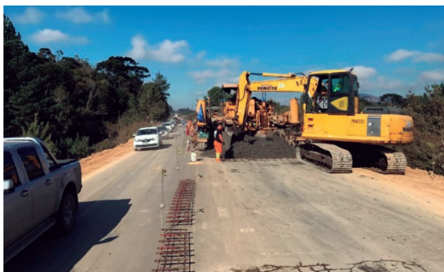
figura 3 - Fluxo de veículos ao lado da execução do whitetopping
