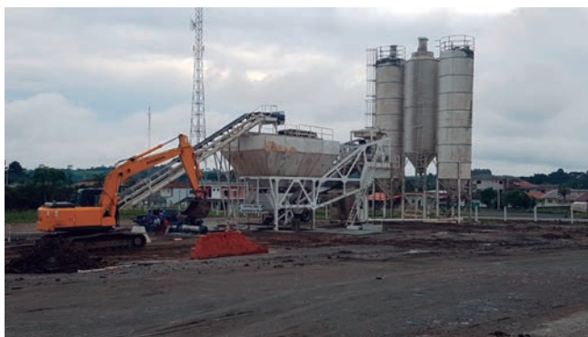
figura 2 - Central misturadora e dosadora.
