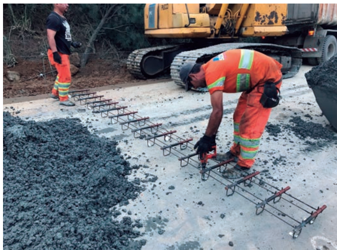
figura 4 – Sistema de apoio das barras de transferência.
