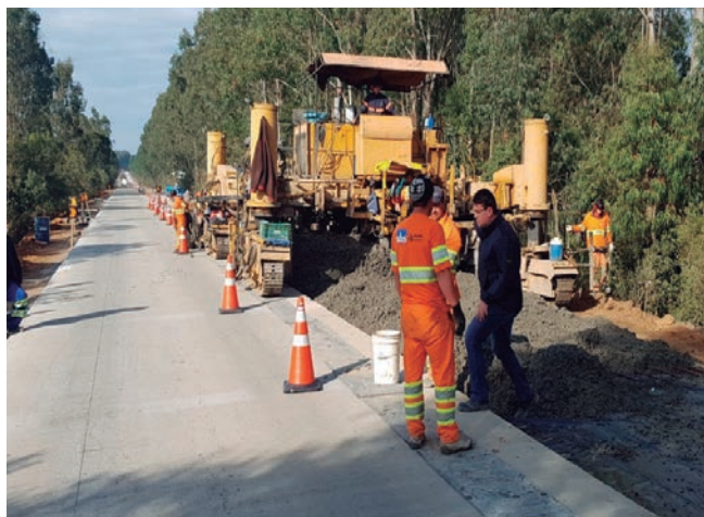
figura 5 - Espalhamento do concreto em frente da pavimentadora
