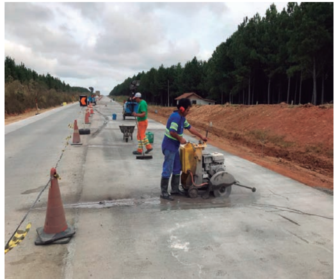
figura 9 - Corte das juntas transversais
