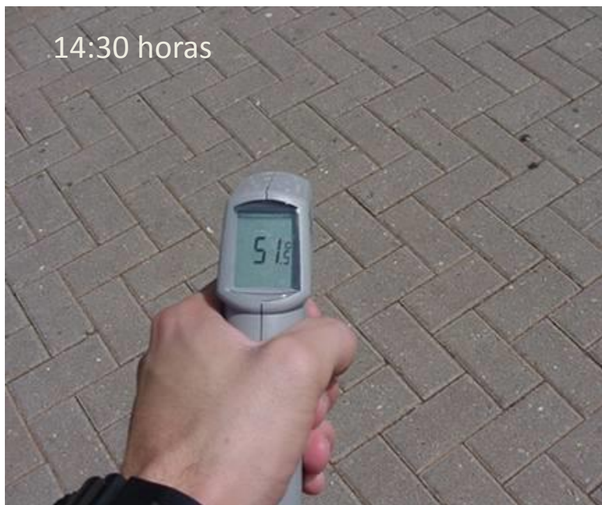
Pavimento de concreto Intertravado
