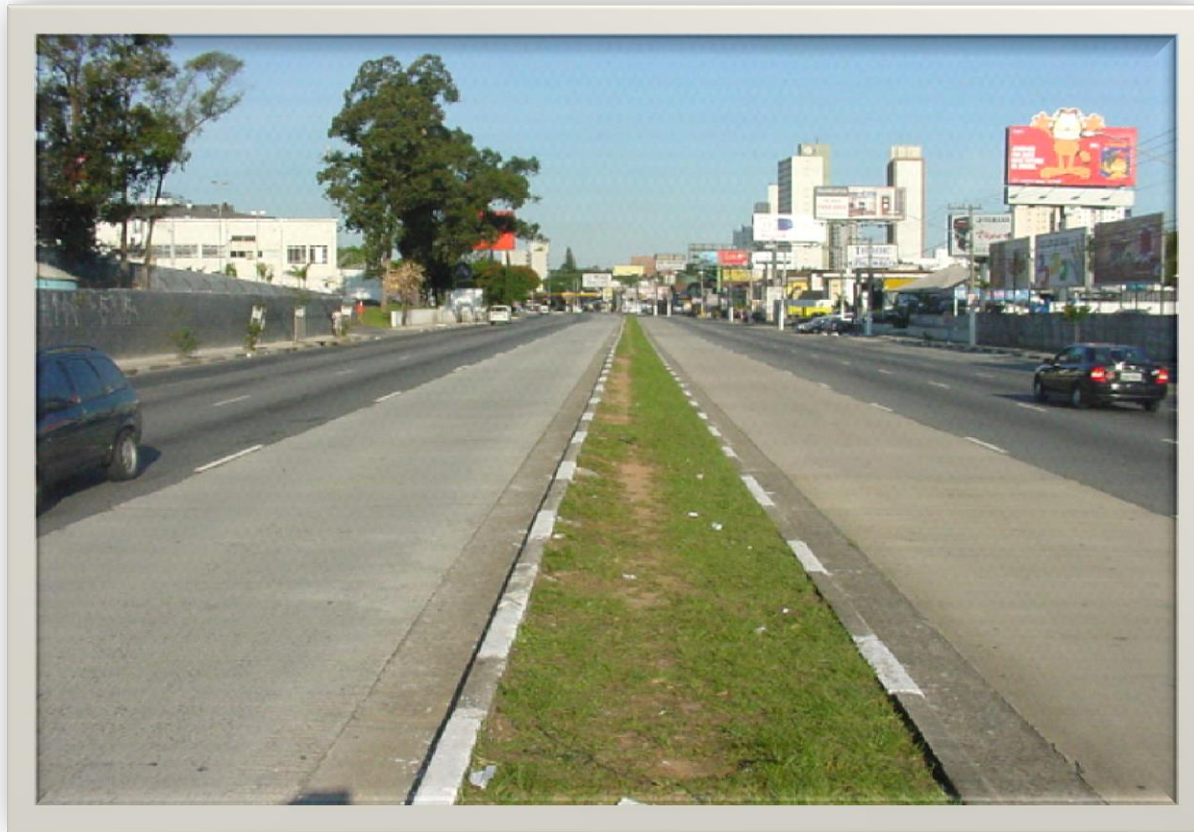
Corredor da Avenida Roque Petroni Junior, São Paulo / SP
