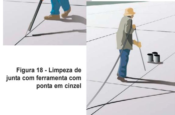
Figura 18 - Limpeza de junta com ferramenta com ponta em cinzel
