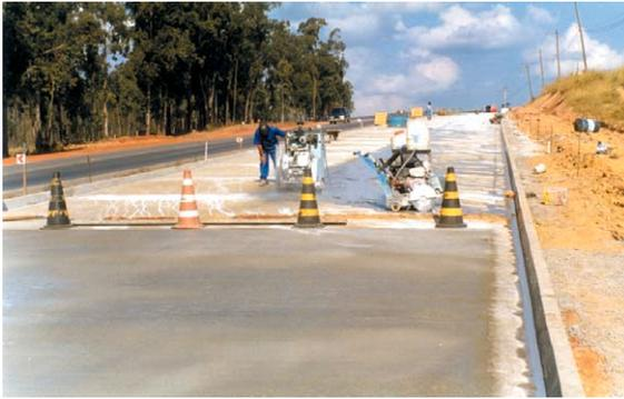
Figura 5 - Corte de junta longitudinal delimitadora das faixas de tráfego (posterior ao das juntas transversais)
