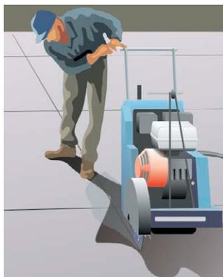
Figura 3 - Corte de junta transversal com serra de disco diamantado. Não se observa a haste-guia, o que dificulta a ação do operador
