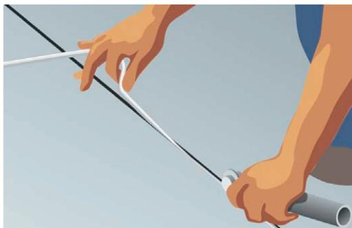
Figura 20 - Colocação de corpo-de-apoio nas juntas, por meio de apetrecho tipo cortador de pizza
