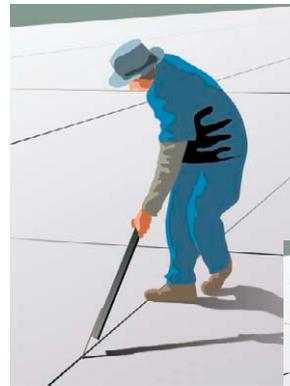
Figura 17 - Limpeza de juntas; as juntas deverão estar secas e limpas.
