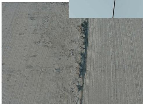
Figura 22 - Junta esborcinada. Para sua selagem é preciso recuperá-la primeiro
