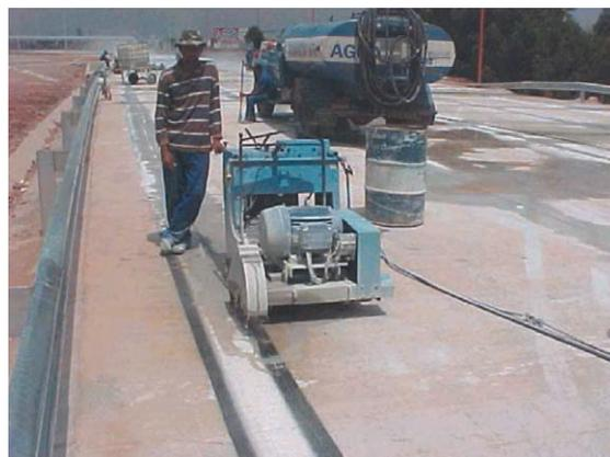
Figura 4 - Corte de junta longitudinal para delimitar a faixa de segurança
