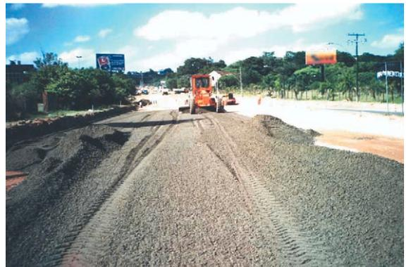
Figura 8 – Espalhamento do concreto com motoniveladora
