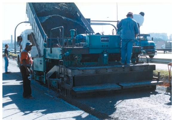
Figura 10 – Espalhamento do concreto com vibroacabadora de asfalto
