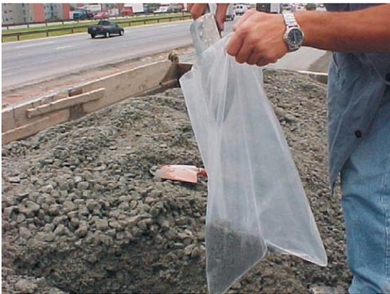
Figura 5 – Amostragem do concreto no caminhão-basculante e acondicionamento em saco plástico
