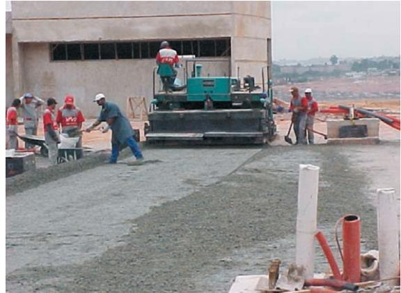
Figura 7 – Coleta de amostra na pista, durante o espalhamento com vibroacabadora de asfalto
