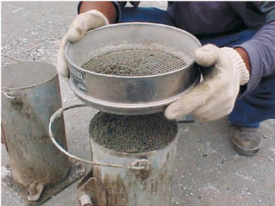
Figura 15 – Peneiramento do concreto sobre a última camada, utilizando-se a peneira de 4,8 mm, para o acabamento visto na figura anterior
