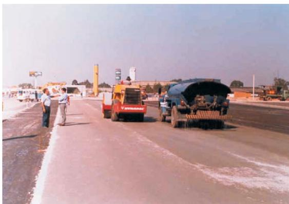
Figura 23 – Cura do concreto com pintura betuminosa
