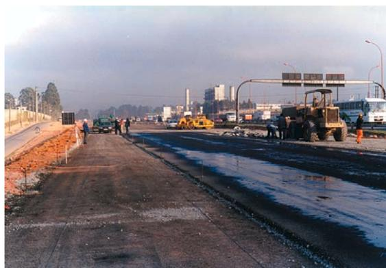
Figura 22 – Molhagem da camada de concreto rolado, antes da aplicação da cura
