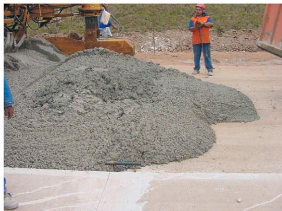
Figura 7 – Análise visual do concreto recém-chegado na pista
