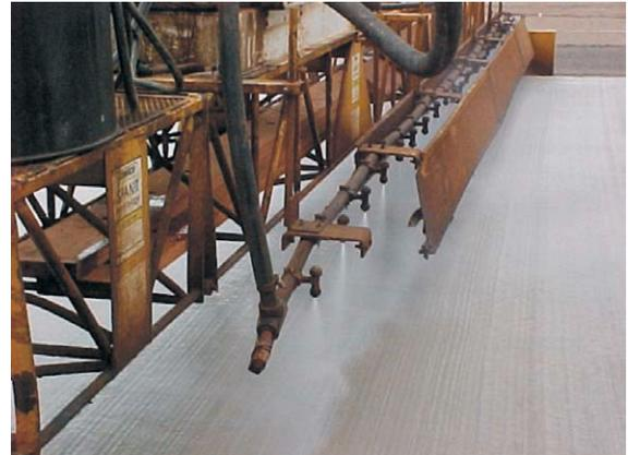
Figura 10 – Cura química por meio de máquina aplicadora
