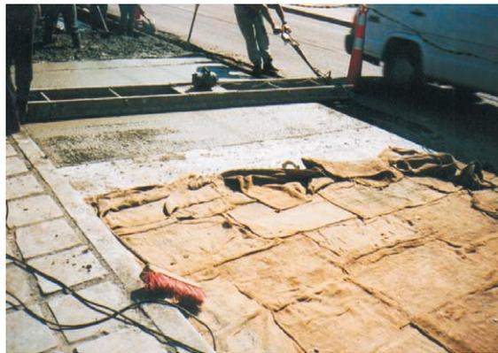
Figura 14 – Cura úmida com mantas constantemente umedecidas
