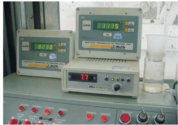
Figura 6 – Comando computadorizado de central gravimétrica
