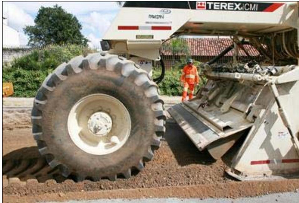
Com a recicladora, o asfalto velho e parte da base são retirados, triturados e misturados com cimento e em seguida devolvidos para a nova base da mesma rua.
