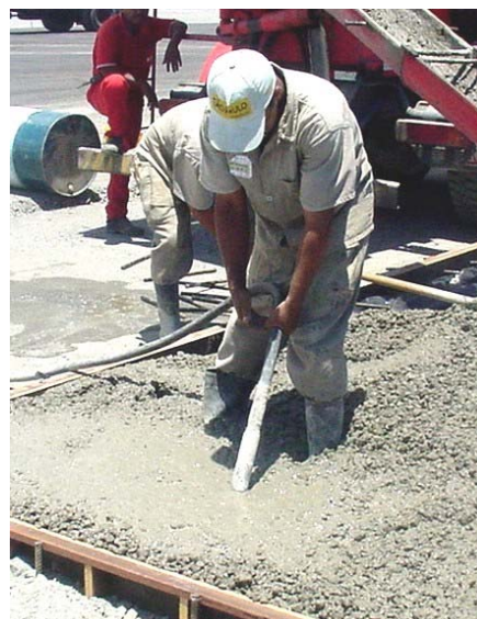
Figura 26 - Posicionamento correto do vibrador
