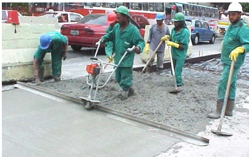
Figura 15 – Régua vibratória simples ou de acabamento
