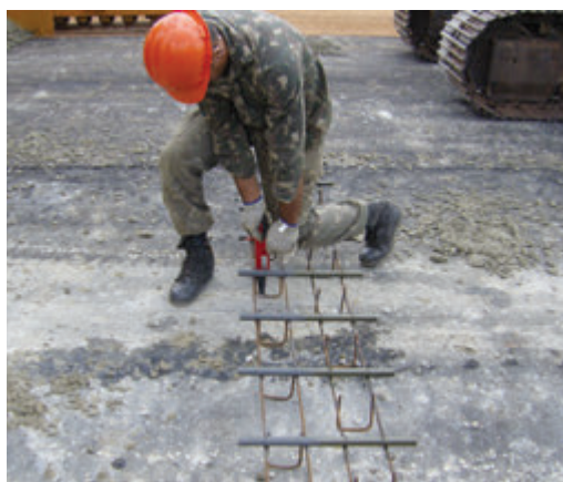
↑ Fijación de las dovelas de transferencia de carga con pistola de presión.
