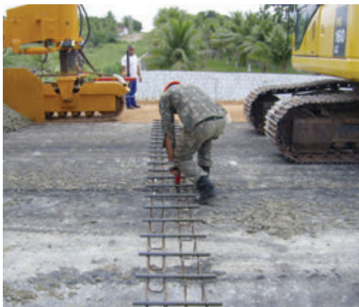
↑ Fijación de las dovelas de transferencia de carga con pistola de presión.
