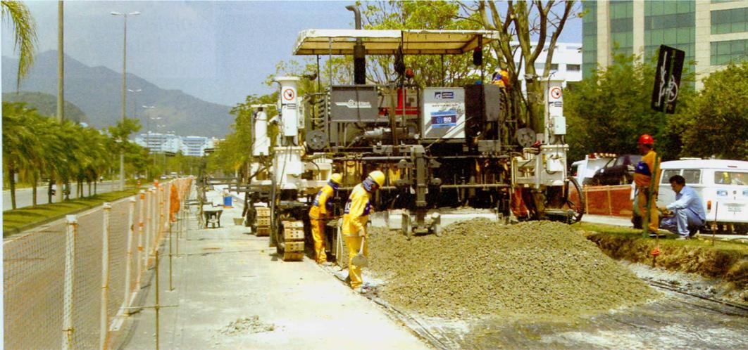
Lançamento do concreto à frente da pavimentadora de formas deslizantes.
