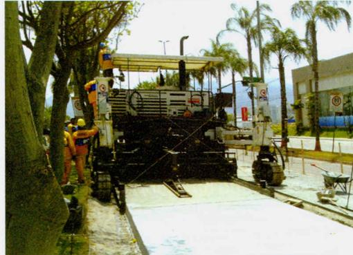
Placa extrusada pela pavimentadora e acabamento superficial do pavimento.
