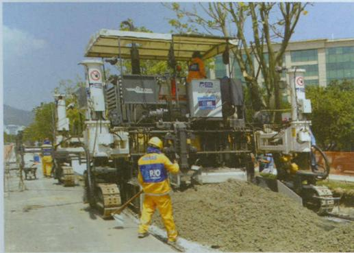
Alimentação correta da pavimentadora facilita operação do equipamento.
