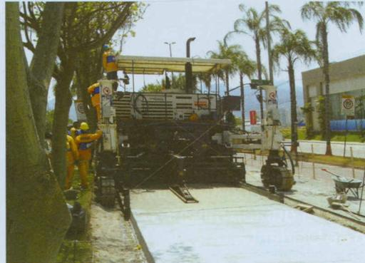
Placa extrusada pela pavimentadora e acabamento superficial do pavimento.
