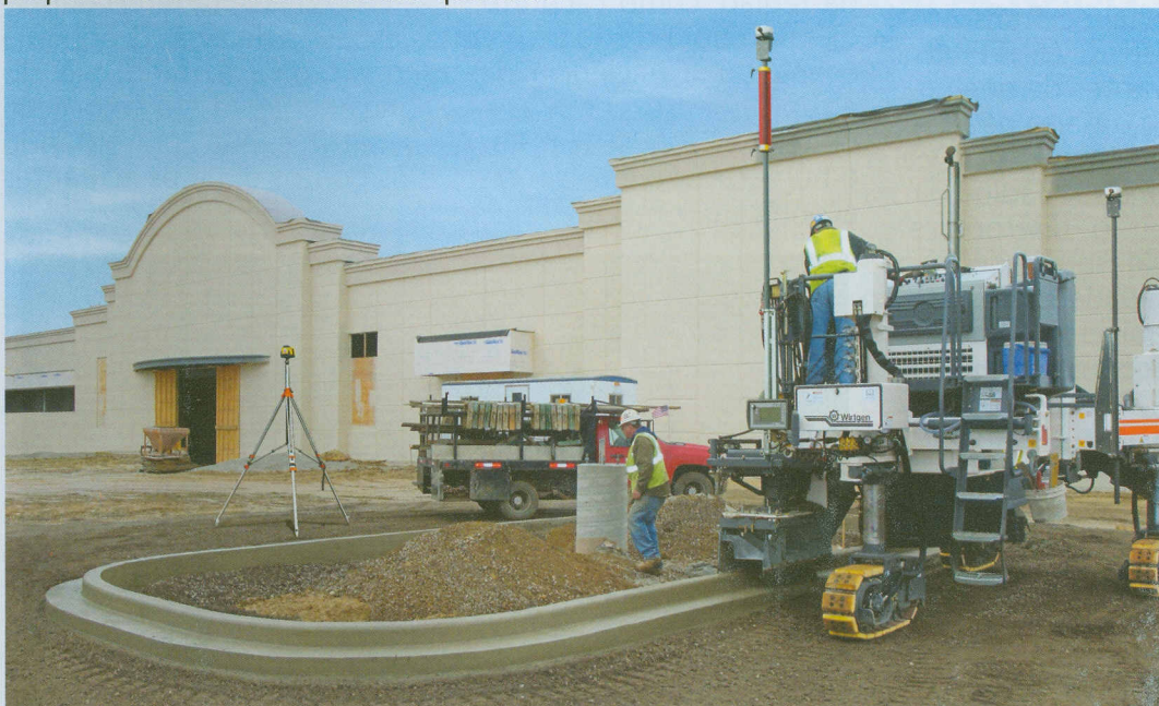
Figura 3 - Trabalhando com perfis de bordas retas ou mesmo com perfis complexos com raios muito estreitos, o piloto automático da Wirtgen conduz a máquina com precisão, proporcionando resultados de alta qualidade.
